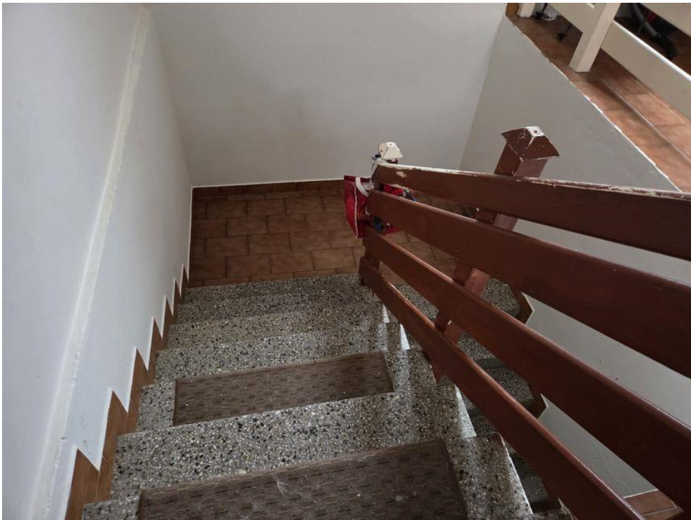
2. NP - schodiště do 1. NP
