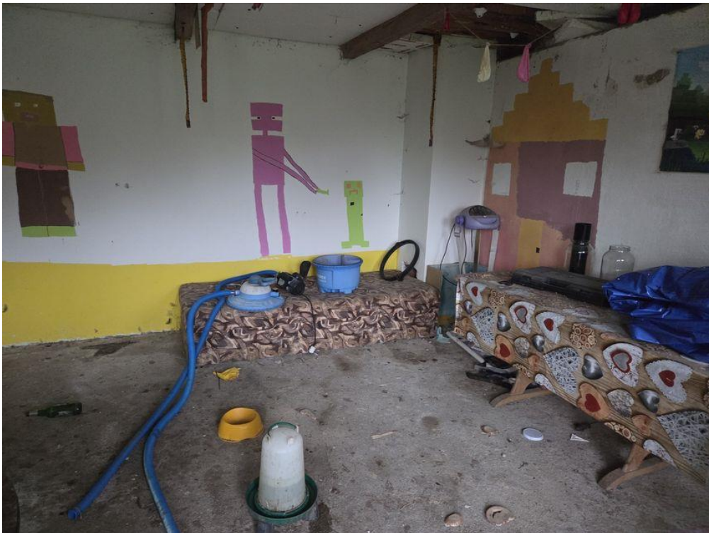
Vnitřní prostor zděná kolna
