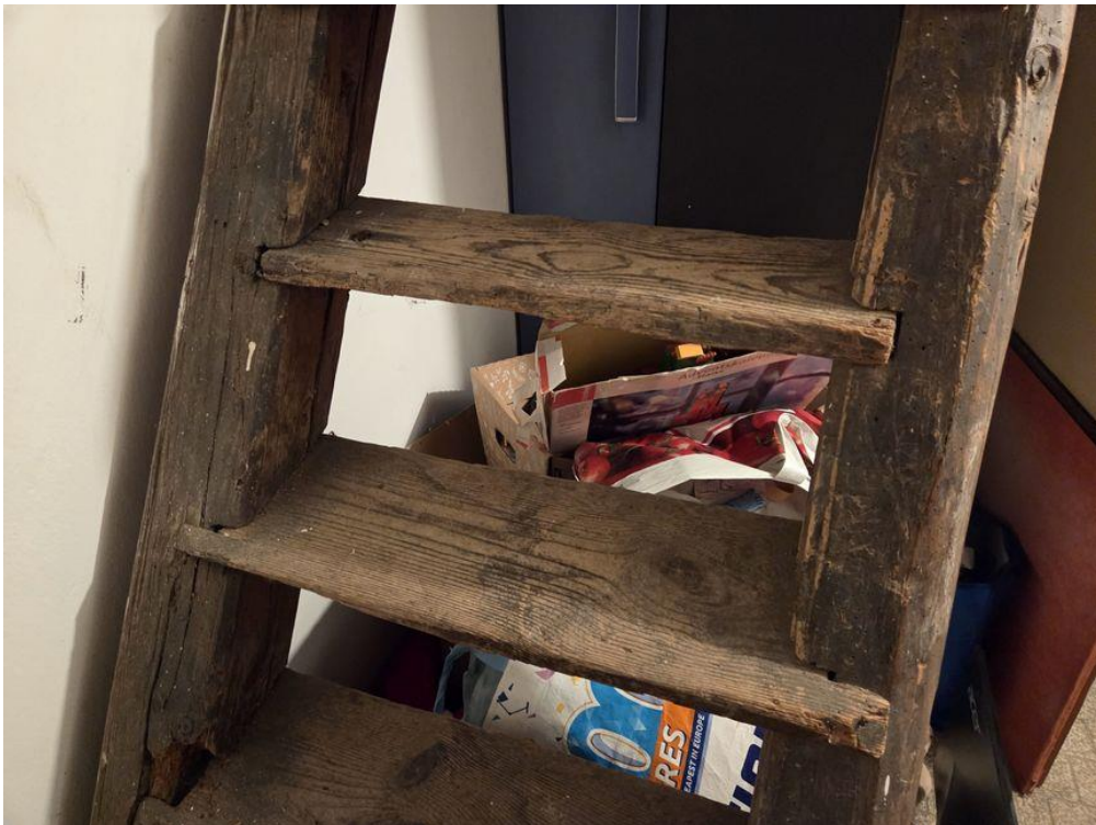
2. NP - komora + schodiště do podkrovní
