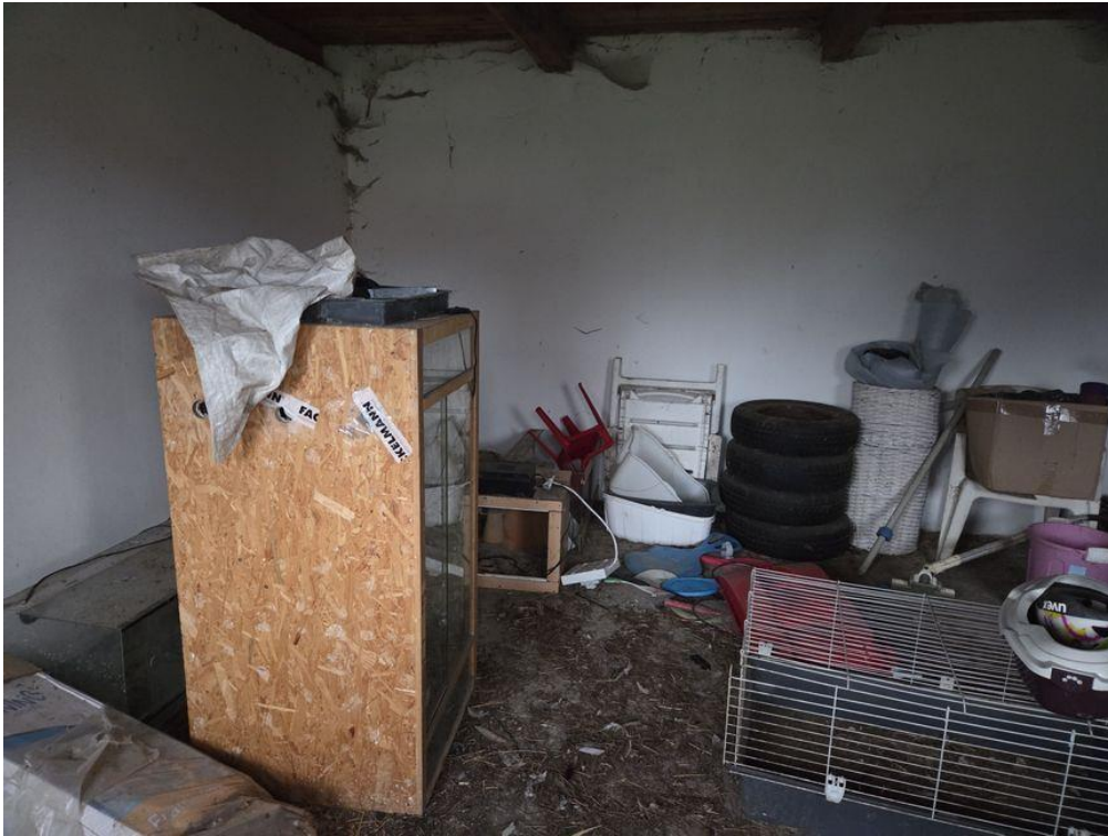
Vnitřní prostor zděná kolna
