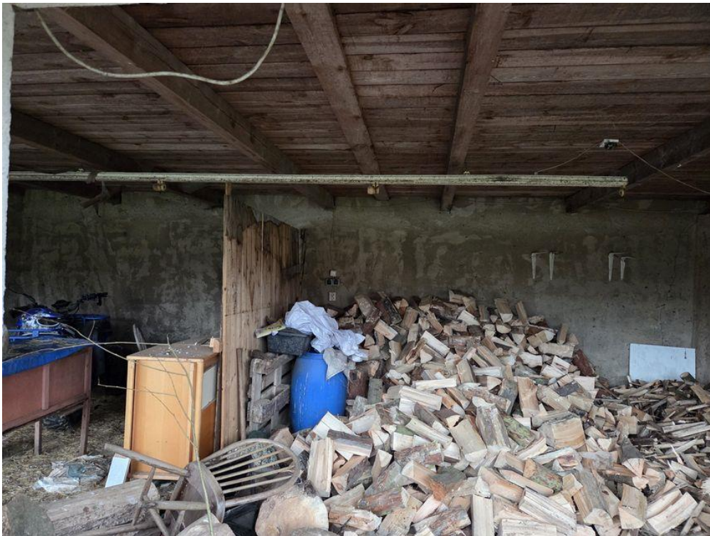
Vnitřní prostor zděná kolna - sklad dřeva
