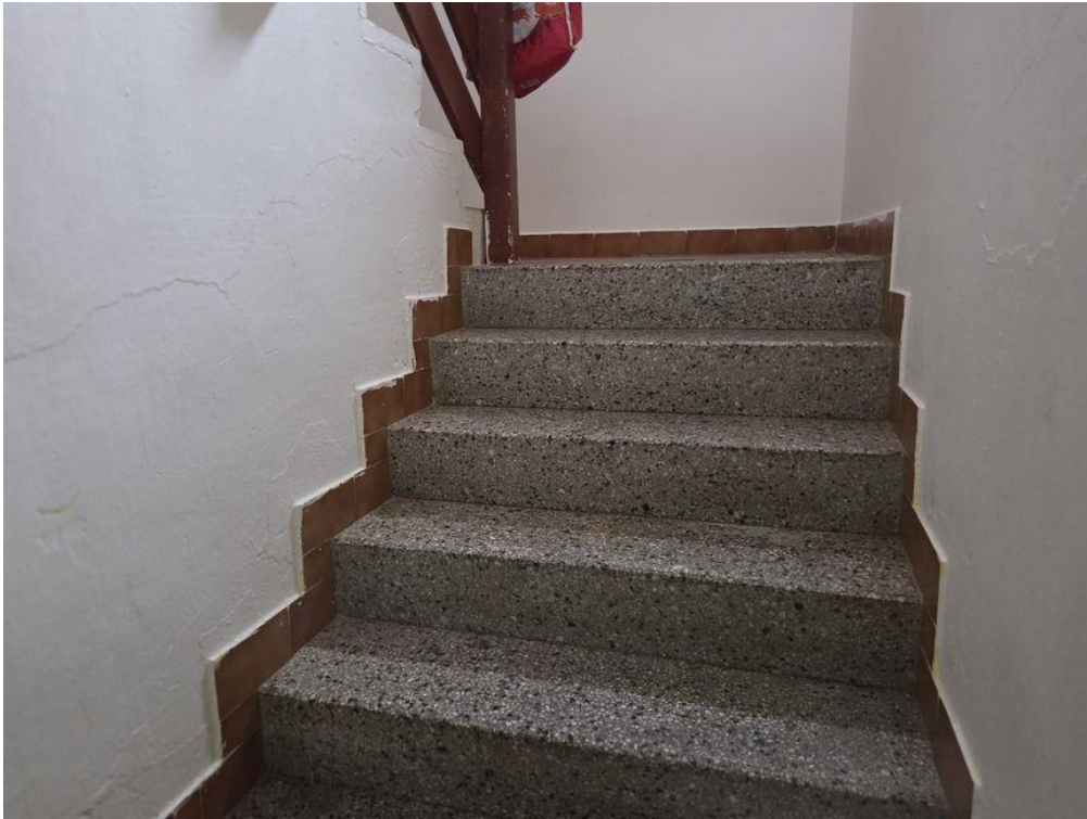
1. NP - schodiště do 2. NP
